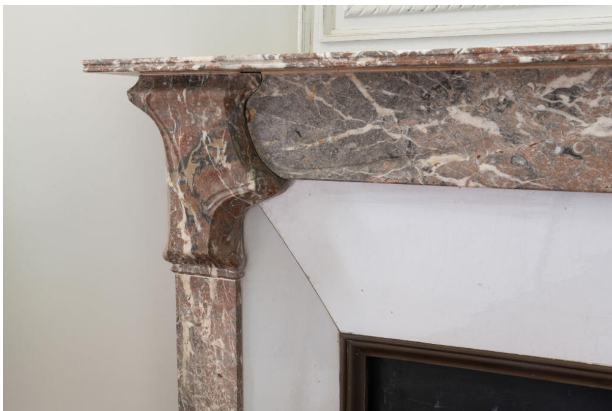
Cheminée d'une chambre de l'étage. Détail de la pénétration du jambage dans le linteau.
