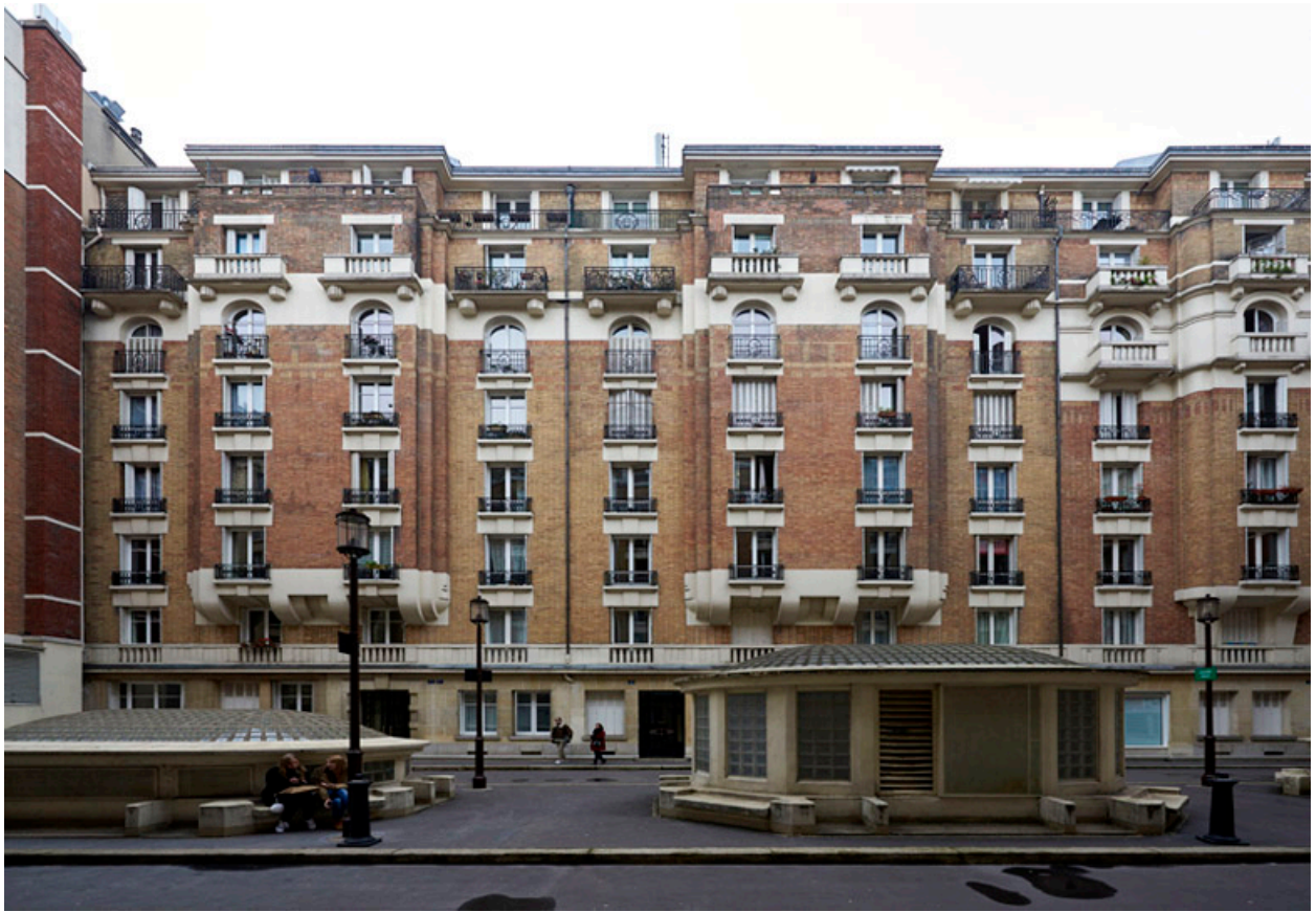
Vue des immeubles côté droit, vers la rue Ernest-Cresson.
