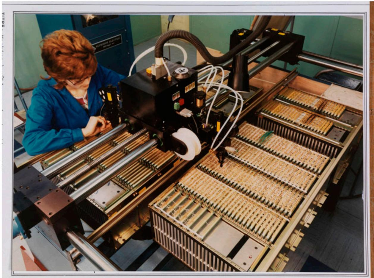
Photo ancienne. Une femme conduit une machine à câbler semi-automatique pour standards téléphoniques. photographie J-S, 1971.
