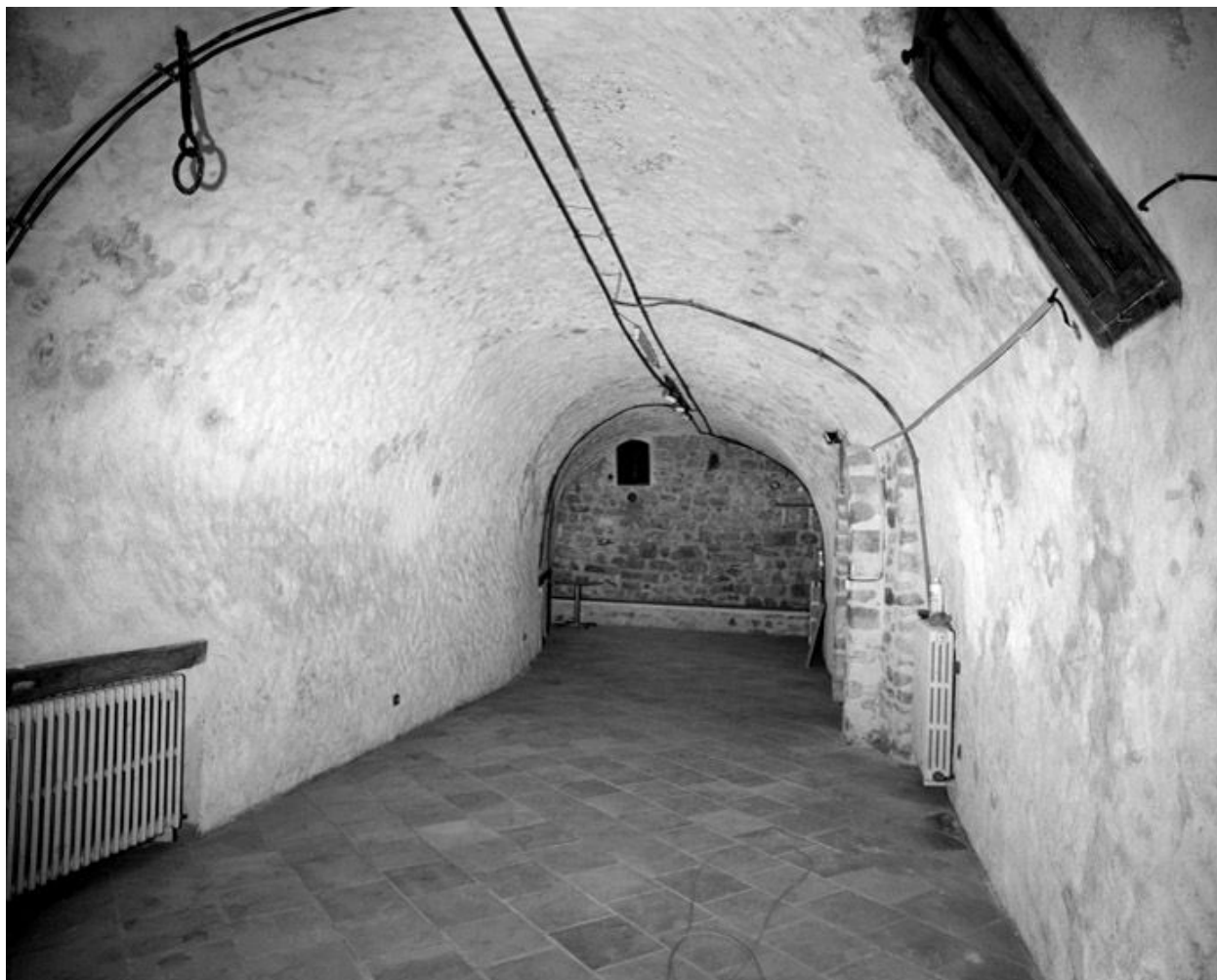
Immeuble du 11 rue Guy-Baudouin, avec cave en berceau et éléments anciens en remploi. Vue de la cave (partie sud). Le mur du fond longe la rue Guy Baudouin.
