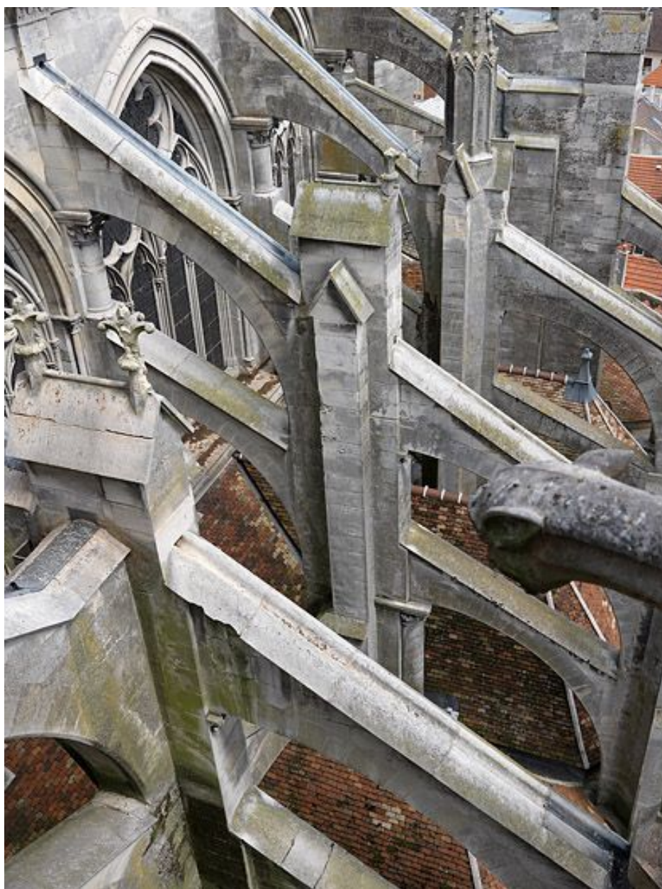
Les arcs-boutants du choeur. Vue prise depuis la balustrade sommitale du bras sud du transept.
