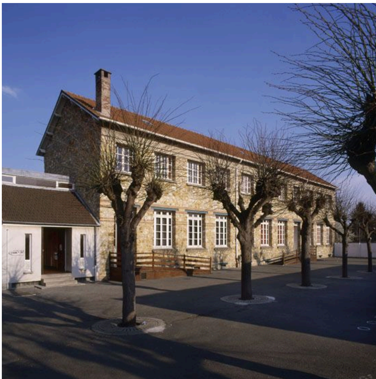
Vue du bâtiment sur cour.
