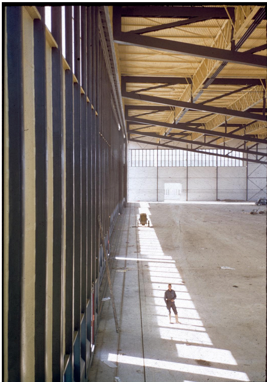
1959, zone industrielle nord de l'aéroport d'Orly, le hangar N6 en construction.
