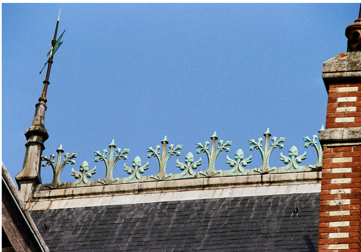
Détail des parties hautes : crête de faîtage.
