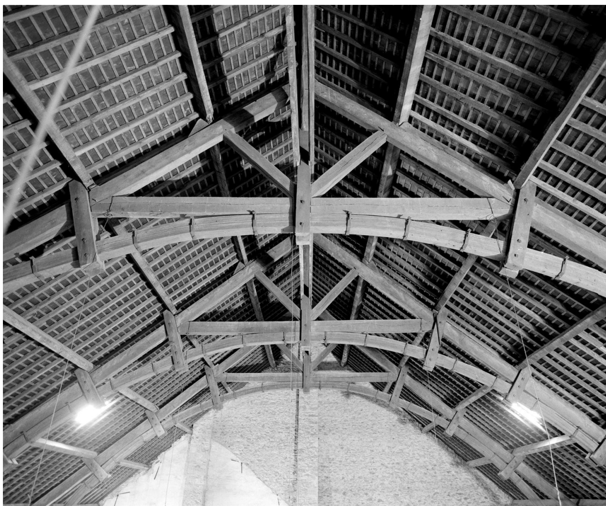
Charpente : vue sur les fermes à entrails retroussés.
