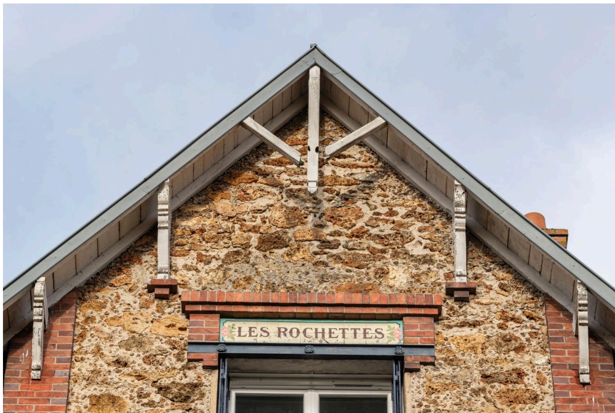
Villa les Rochettes, détail de la façade principale
