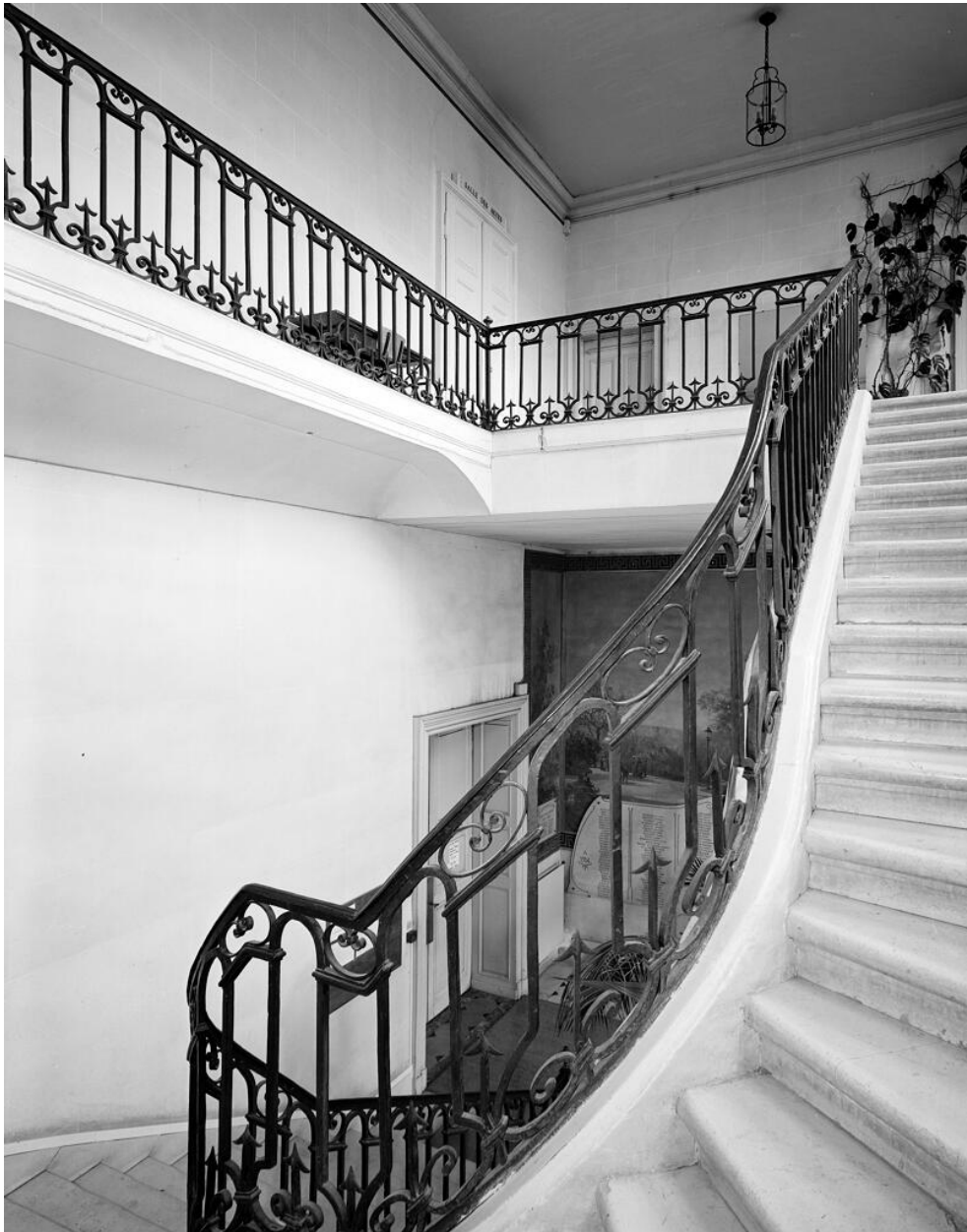
Le pavillon Mansart : volée de l'escalier intérieur, et palier du 1er étage. Château, Lycée dit Château de le Prevost puis DESCONDE, Lycée du Prince Impérial, actuellement Lycée Michelet
