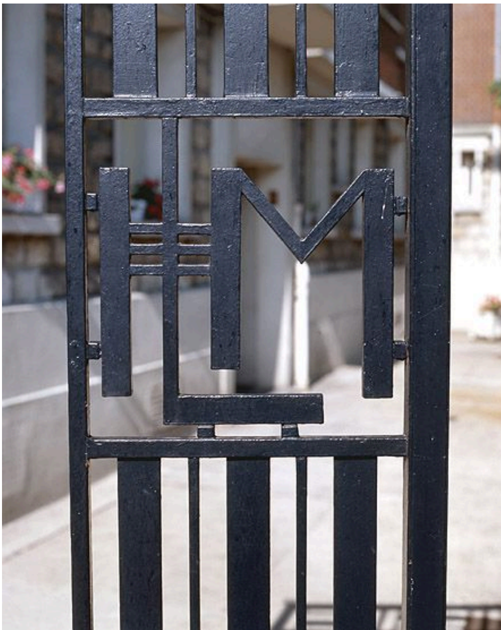
Détail d'une grille d'entrée dans la cité portant le monogramme HLM en serrurerie.
