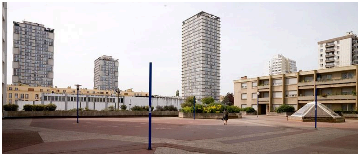
Choisy-le-Roi, secteur urbain concerté dit dalle du centre-ville. La dalle.
