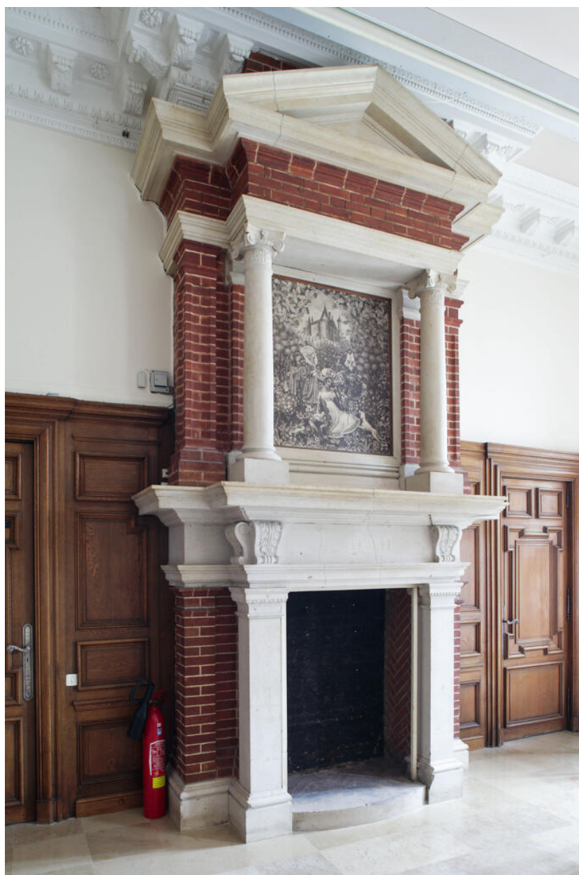
Cheminée monumentale d'inspiration Renaissance.
