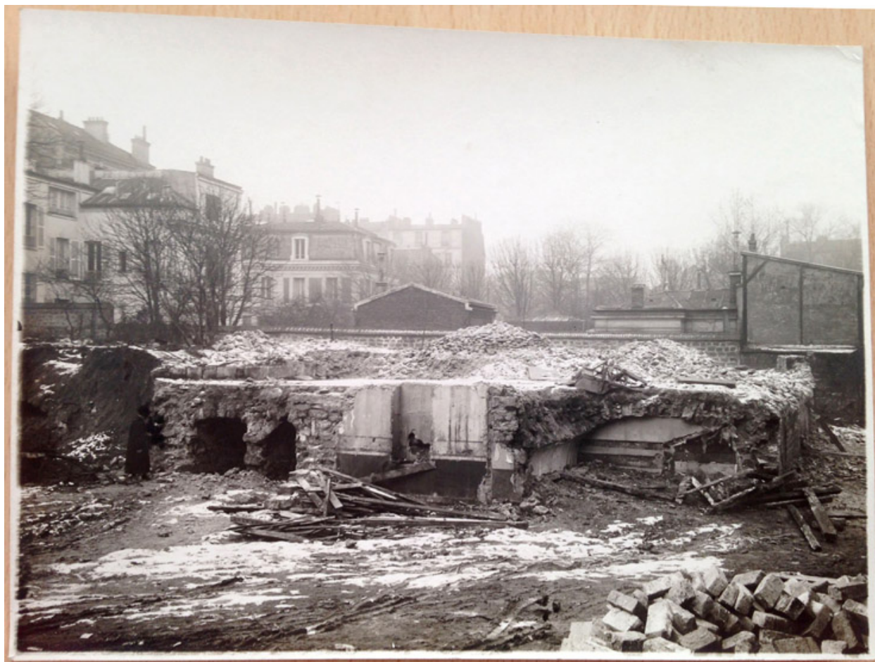
Vue du moulin en cours de destruction. Fonds d'archives de la Commission du Vieux Paris.
