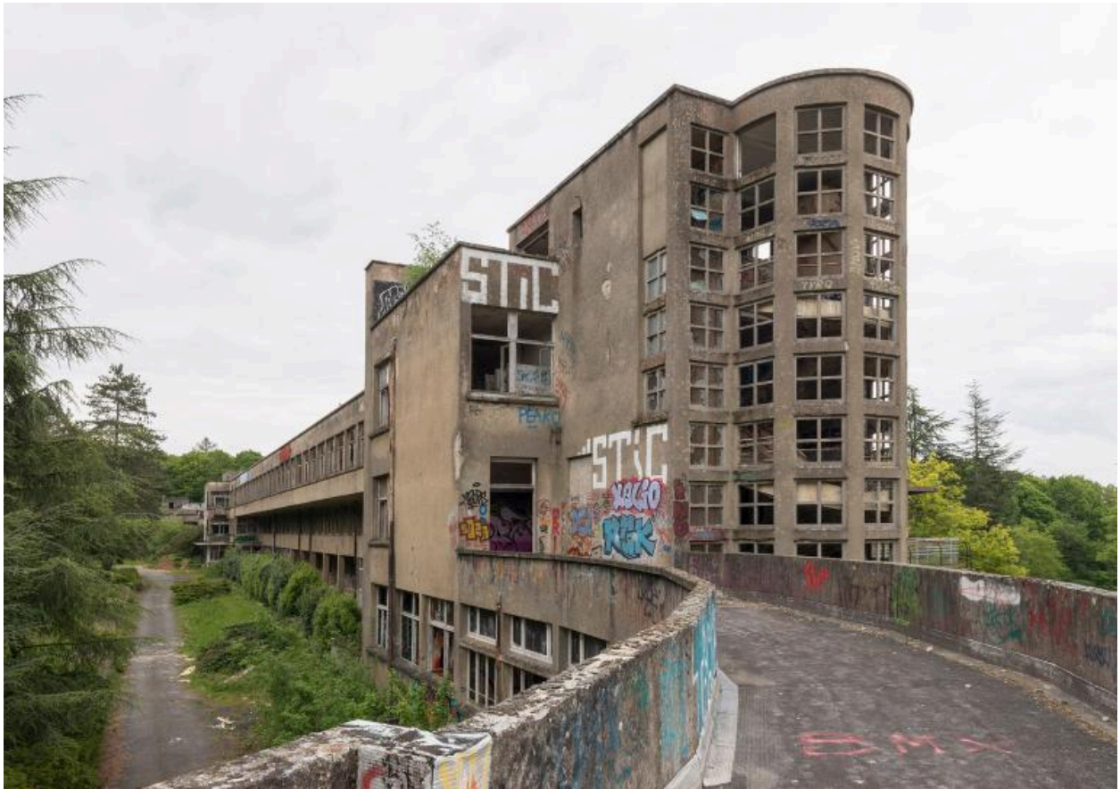
pavillon Bonnefoy-Sibour, vue prise du toit-terrasse vers l'est
