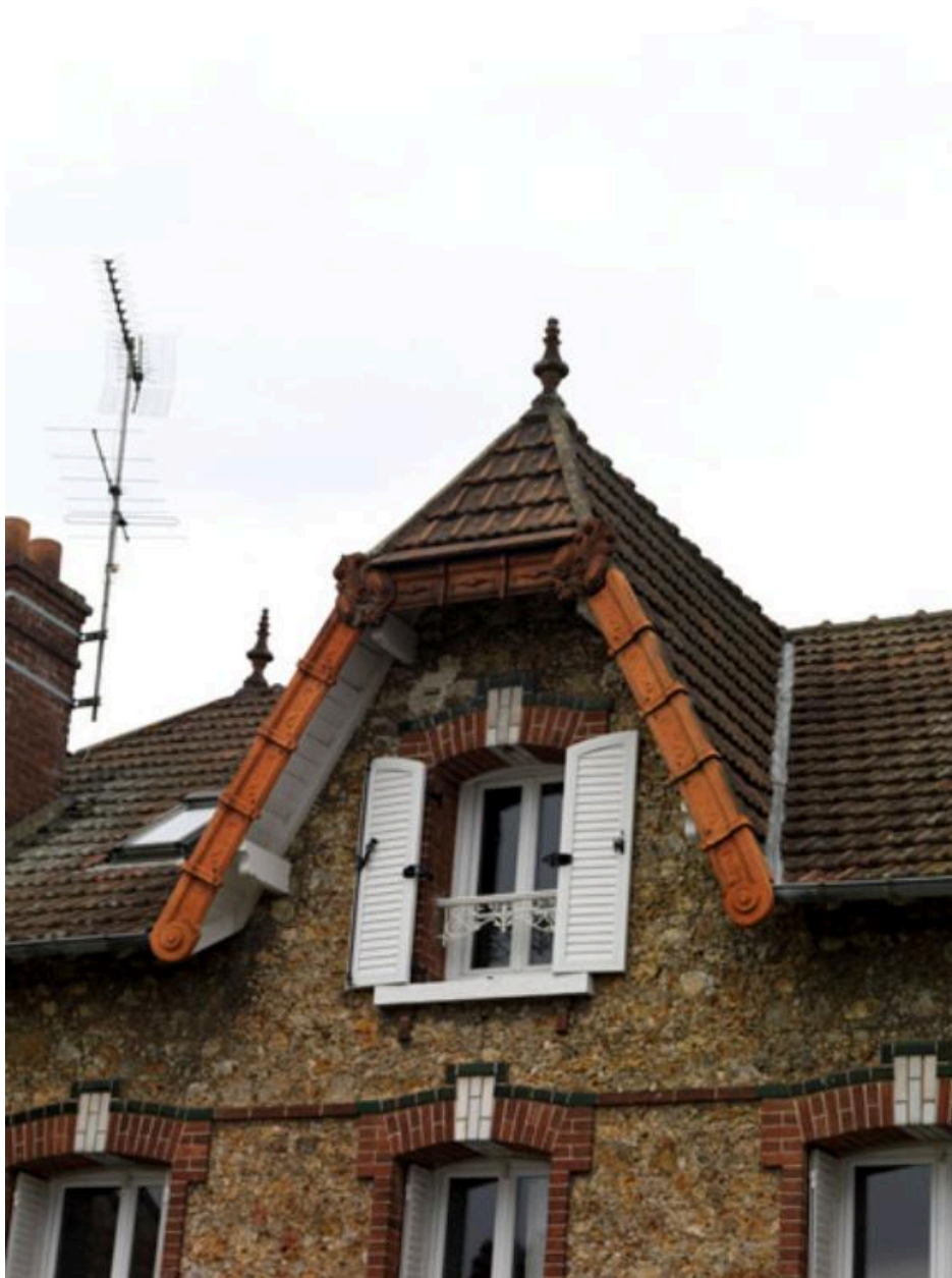
Vue du décor de la lucarne-pignon du n°44.
