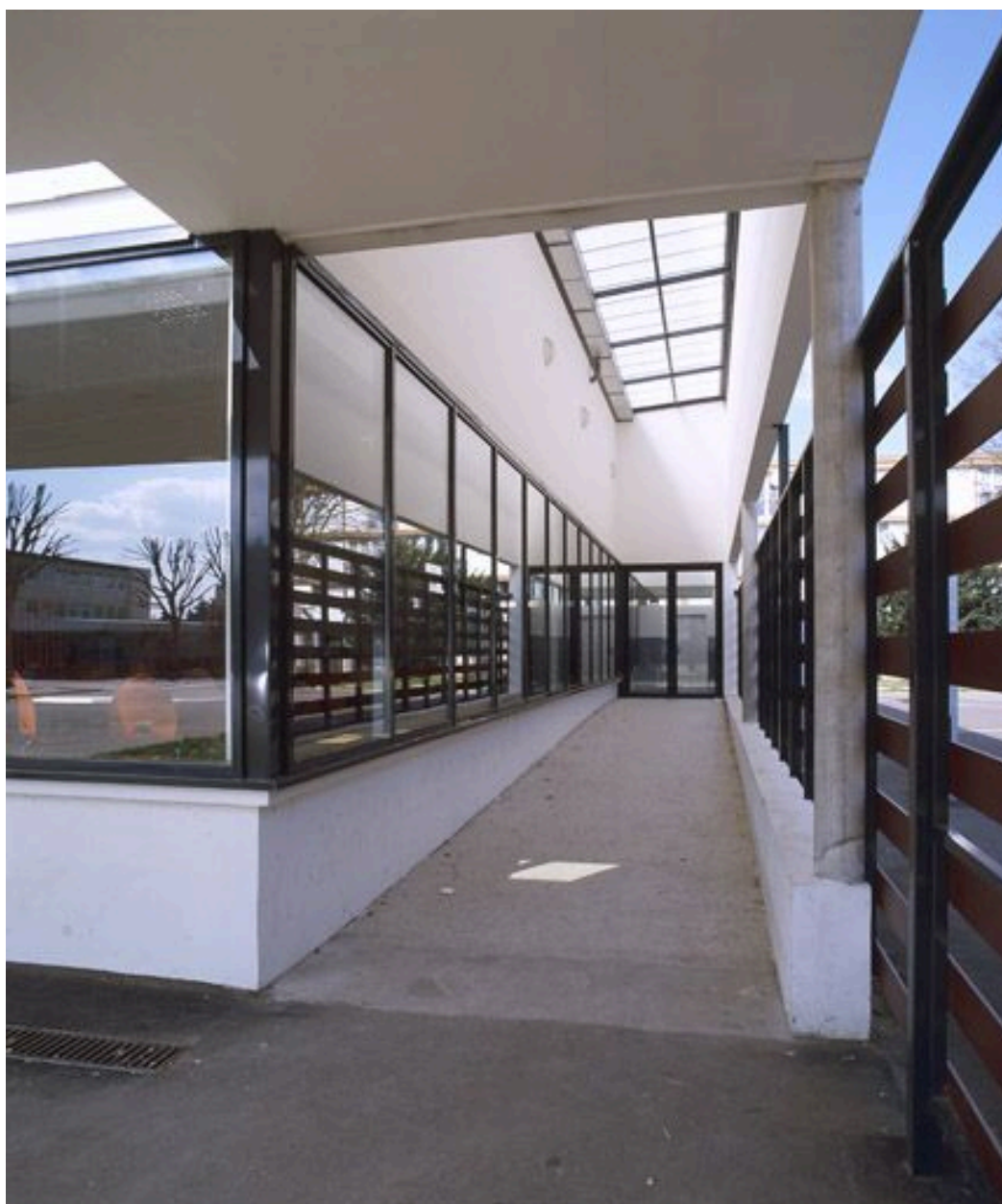
Entrée de l'aile perpendicualire au corps de bâtiment principal.
