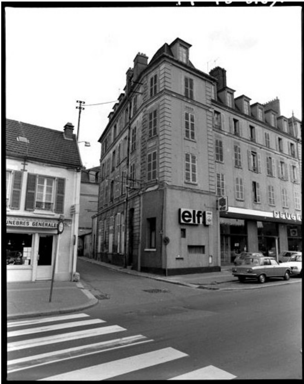
Ancien couvent de Bénédictines, Victor-Duhamel (boulevard) 17. Façade sur le boulevard et la rue du Clos Pinet.
