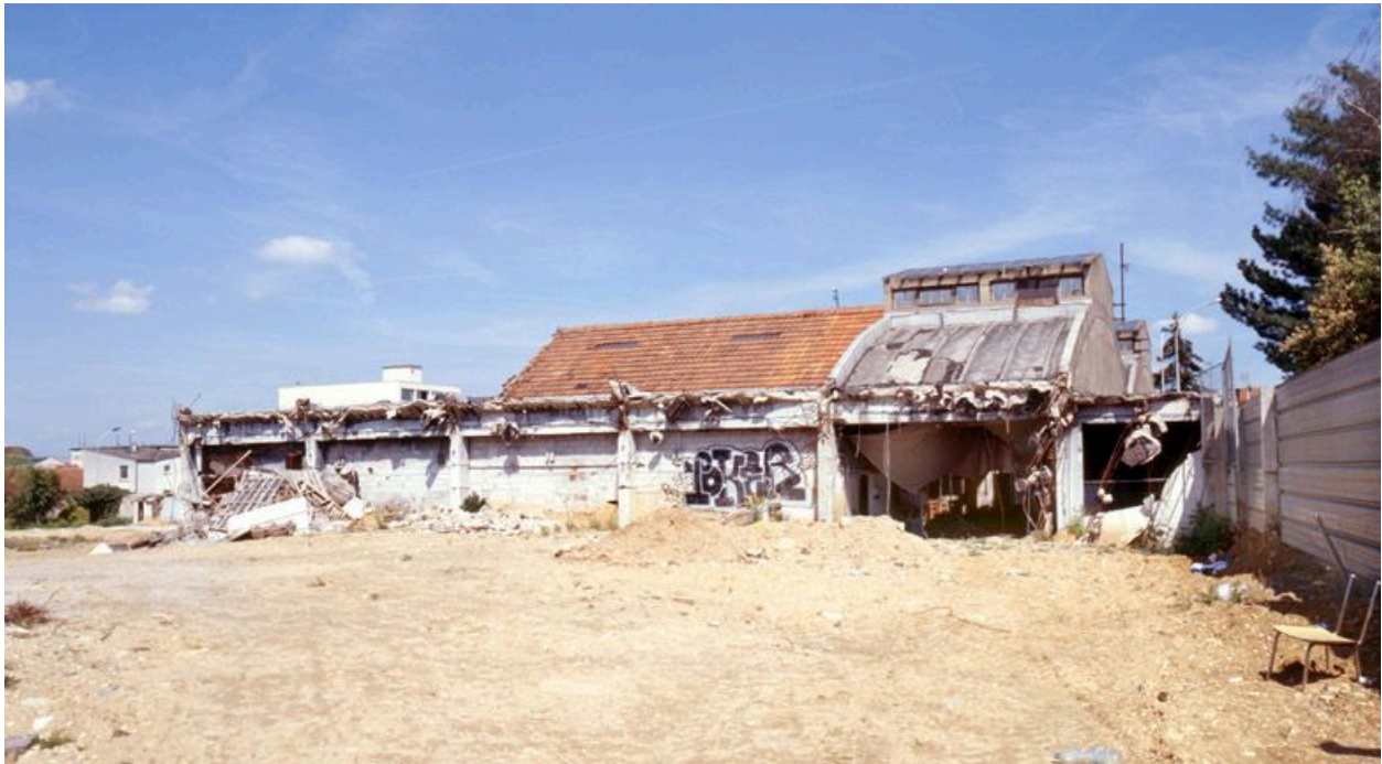
Usine de construction électrique ALG Fabae, 2 rue Garenne. Vue extérieure d'ensemble des bâtiments lors de leur démolition.
