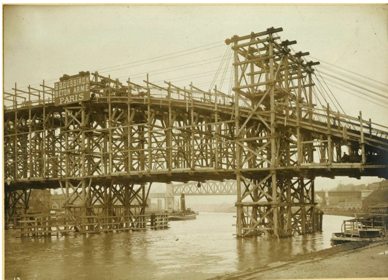
La reconstruction du pont sur l'Oise en 1927. Photographie. (AD Yvelines).
