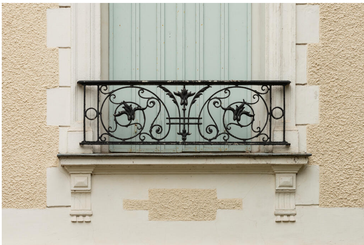
Détail d'un garde-corps du rez-de-chaussée.
