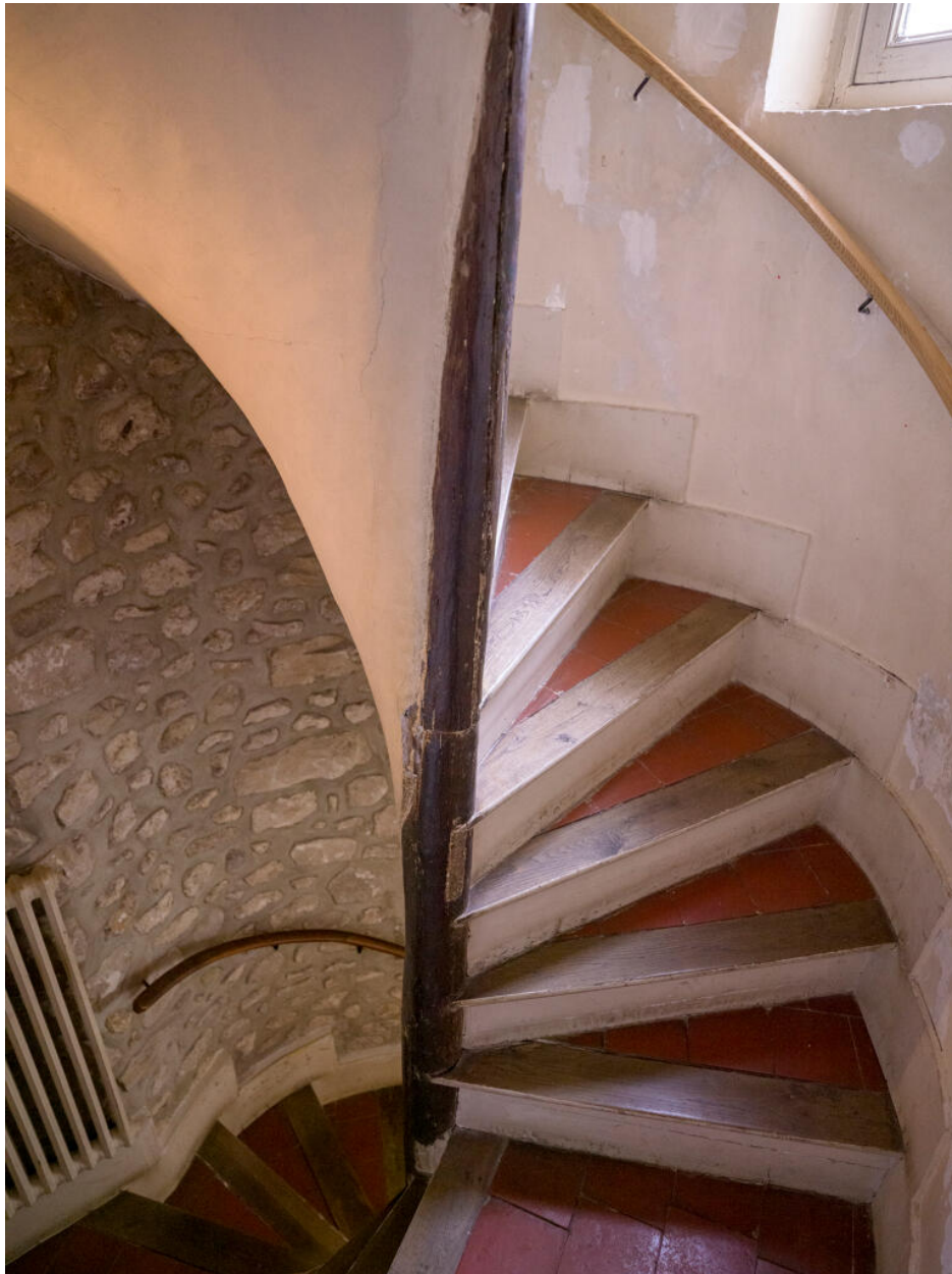
Vue générale de l'escalier en vis.
