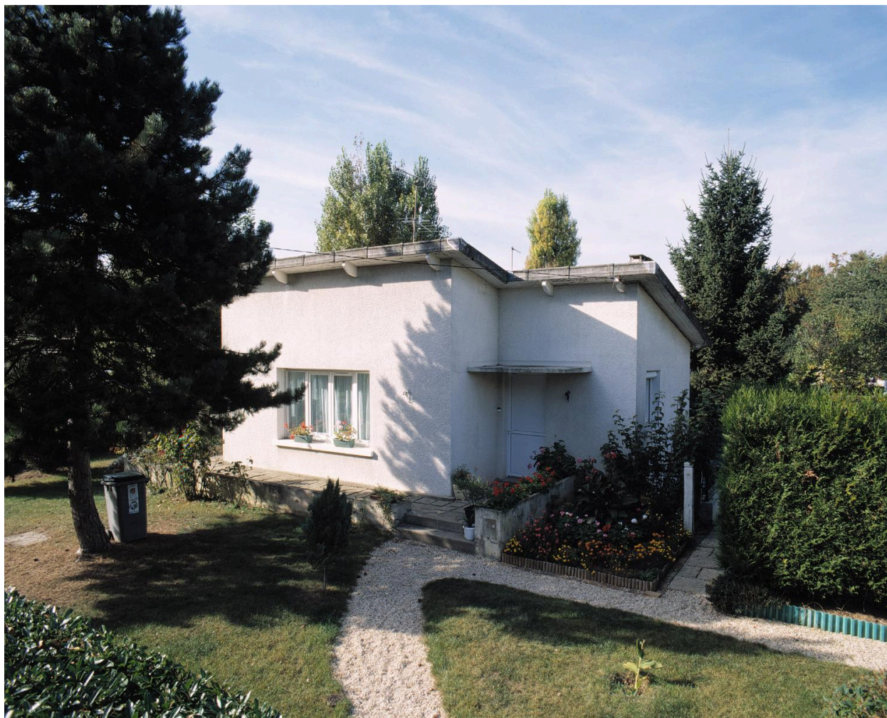
Vue d'ensemble du pavillon situé 15, rue Jean-Le-Duff.
