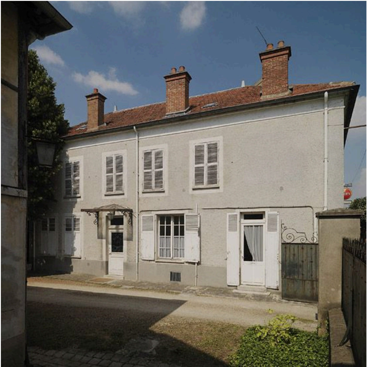
Logement patronal et bureau.
