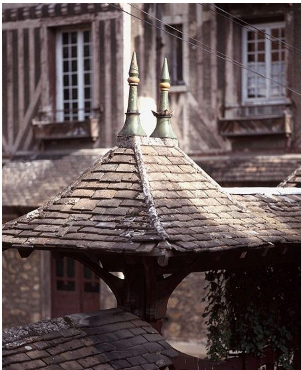
Détail du couronnement du portail d'une maison, 19 rue Victor Basch.
