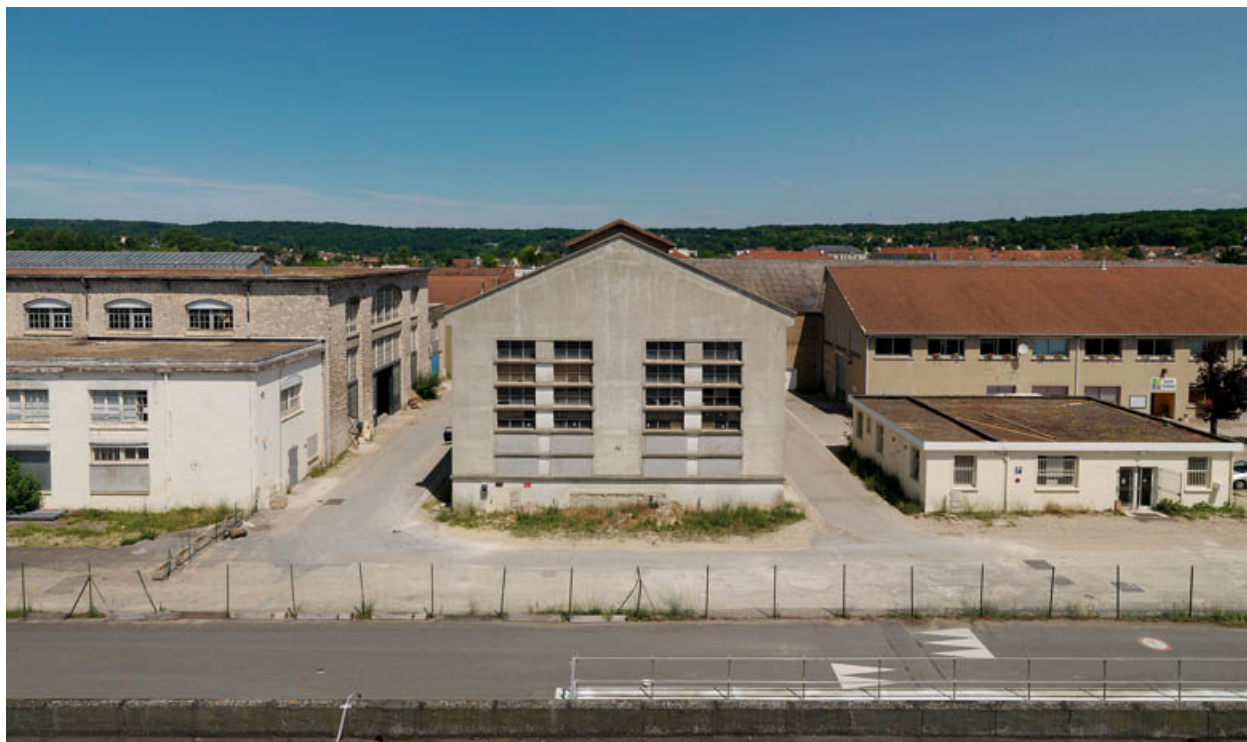
Vue extérieure. La chaufferie (1951).
