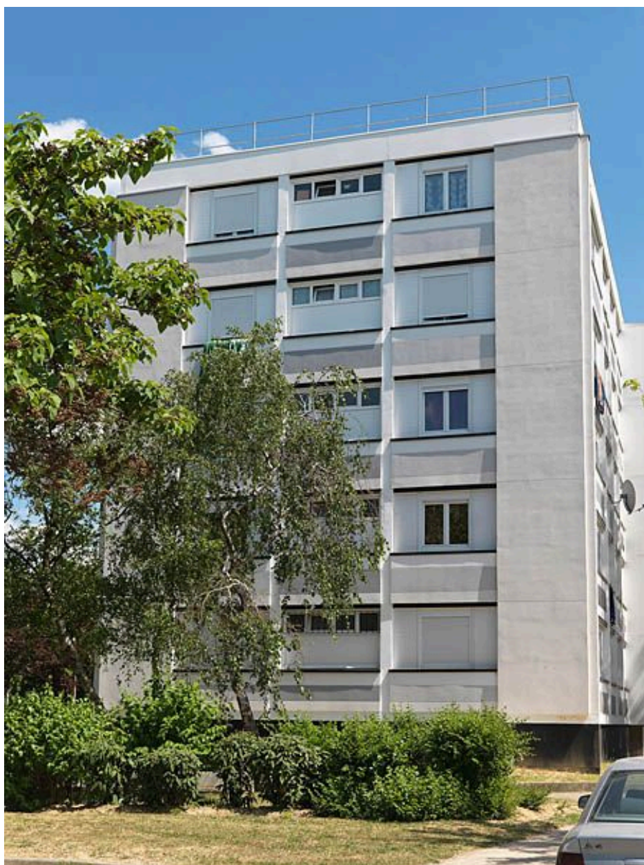
Cité dite Résidence Saint-Hubert. Façade arrière rénovée d'une barre R+5 et aire de jeux. Travées de fenêtres de cuisines et de chambres.
