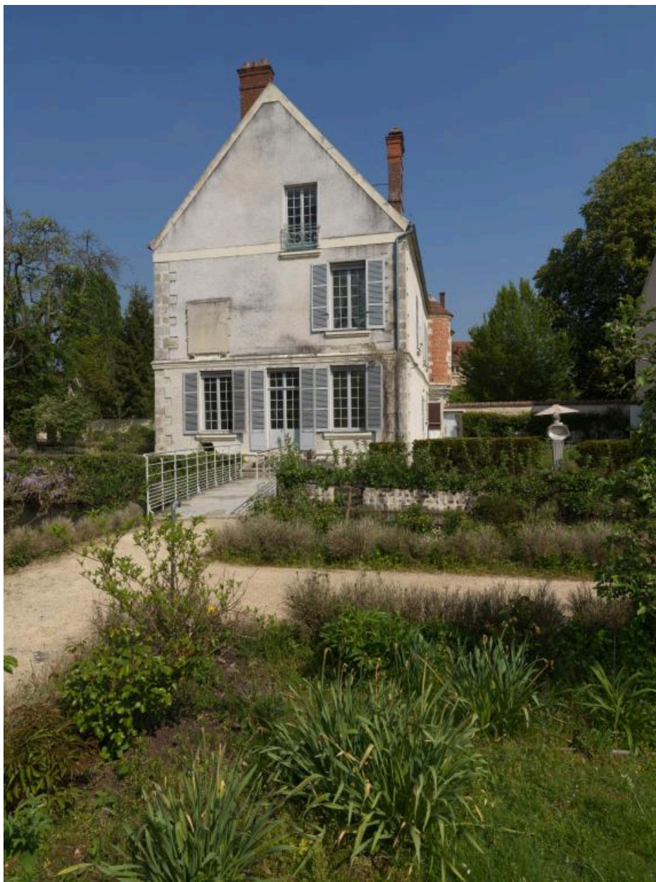
Vue du mur pignon du bâtiment principal (1)
