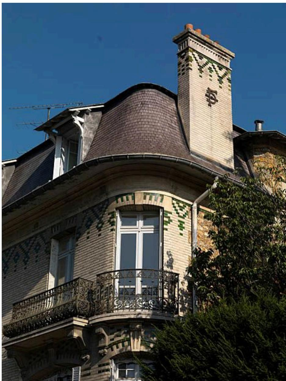
Détail du traitement d'angle : la croupe ronde brisée et la cheminée avec initiales FD en fers d'ancrage (angle sud-est de la villa).
