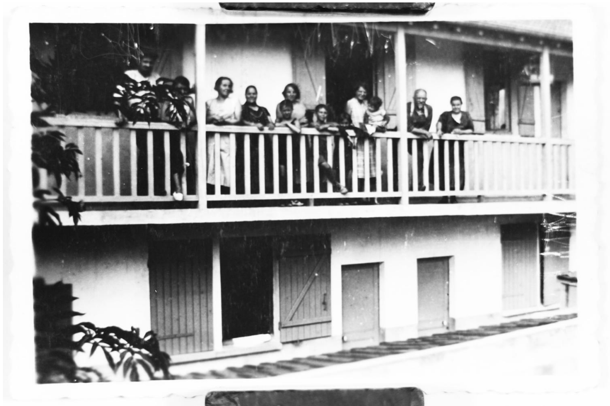
Vue du bâtiment d'habitation en aile, composé de six chambres et deux cuisines, détruit par le bombardement.
