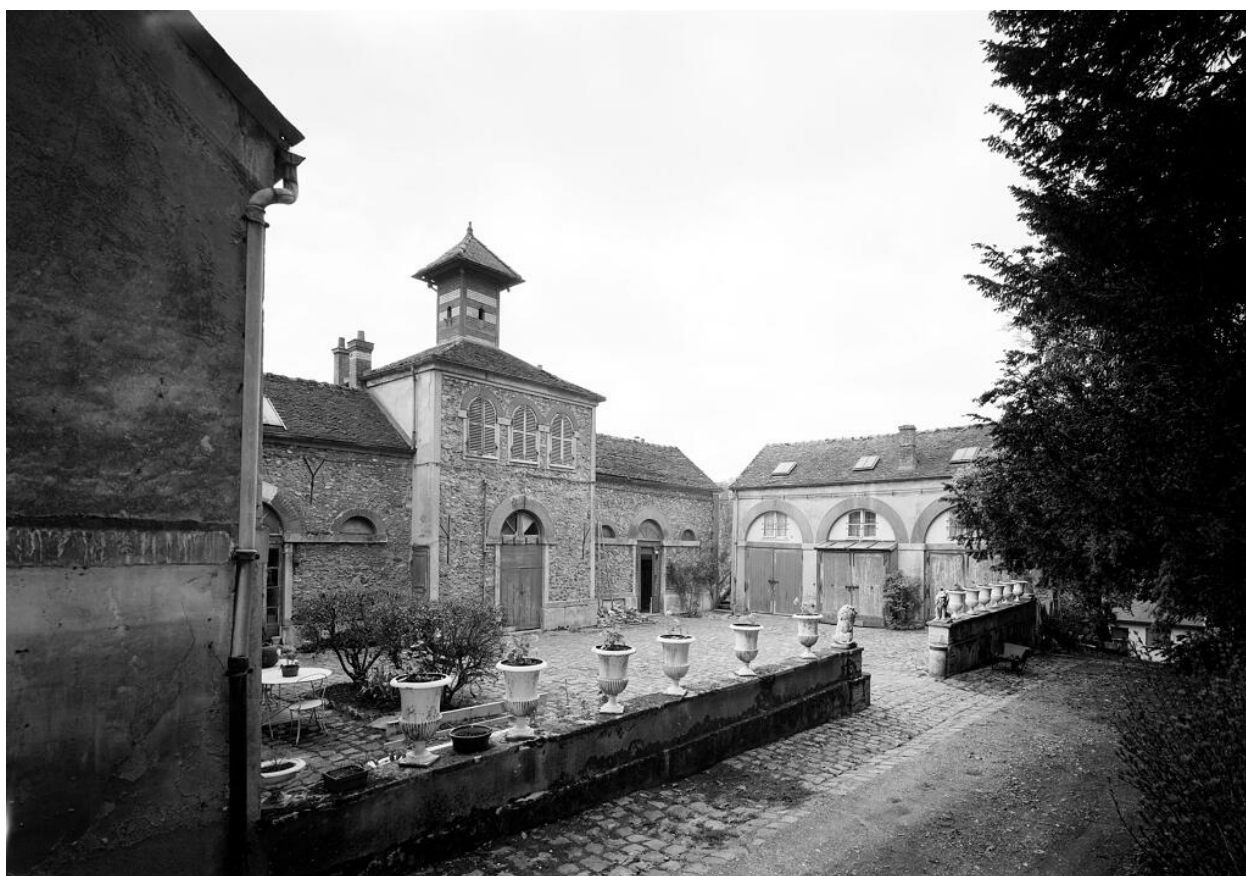
Corps central et corps latéral droit.
