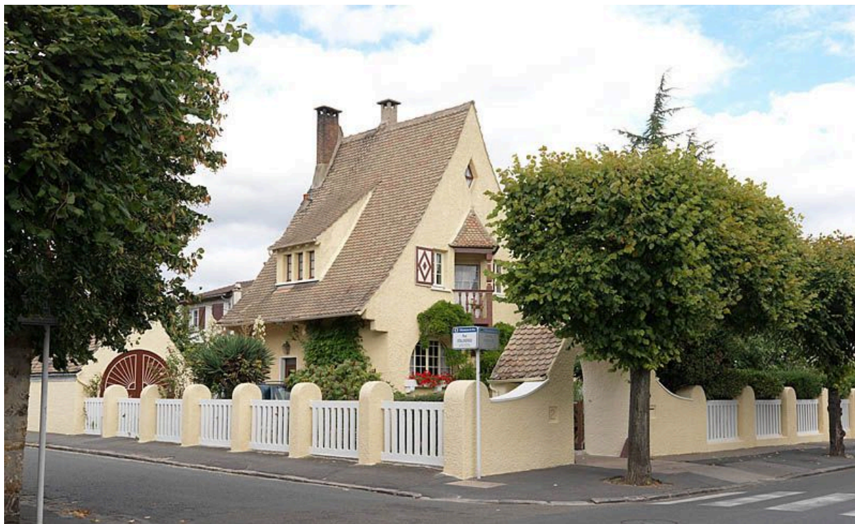
Villeneuve-le-Roi, maison, 12 avenue Pasteur, rue de Stalingrad. Vue d'ensemble.
