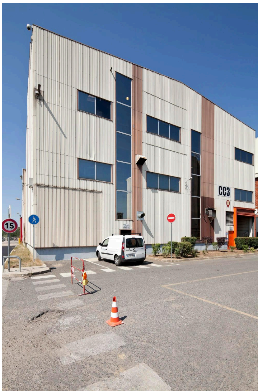
Atelier, 1979. (réf. Département de Seine-et-Marne : IVD77_2013_77_00345_NUCA)
