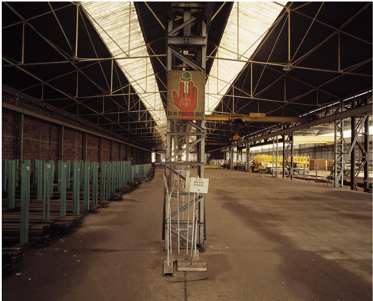
Etablissements Champion : vue intérieure du hangar de stockage.
