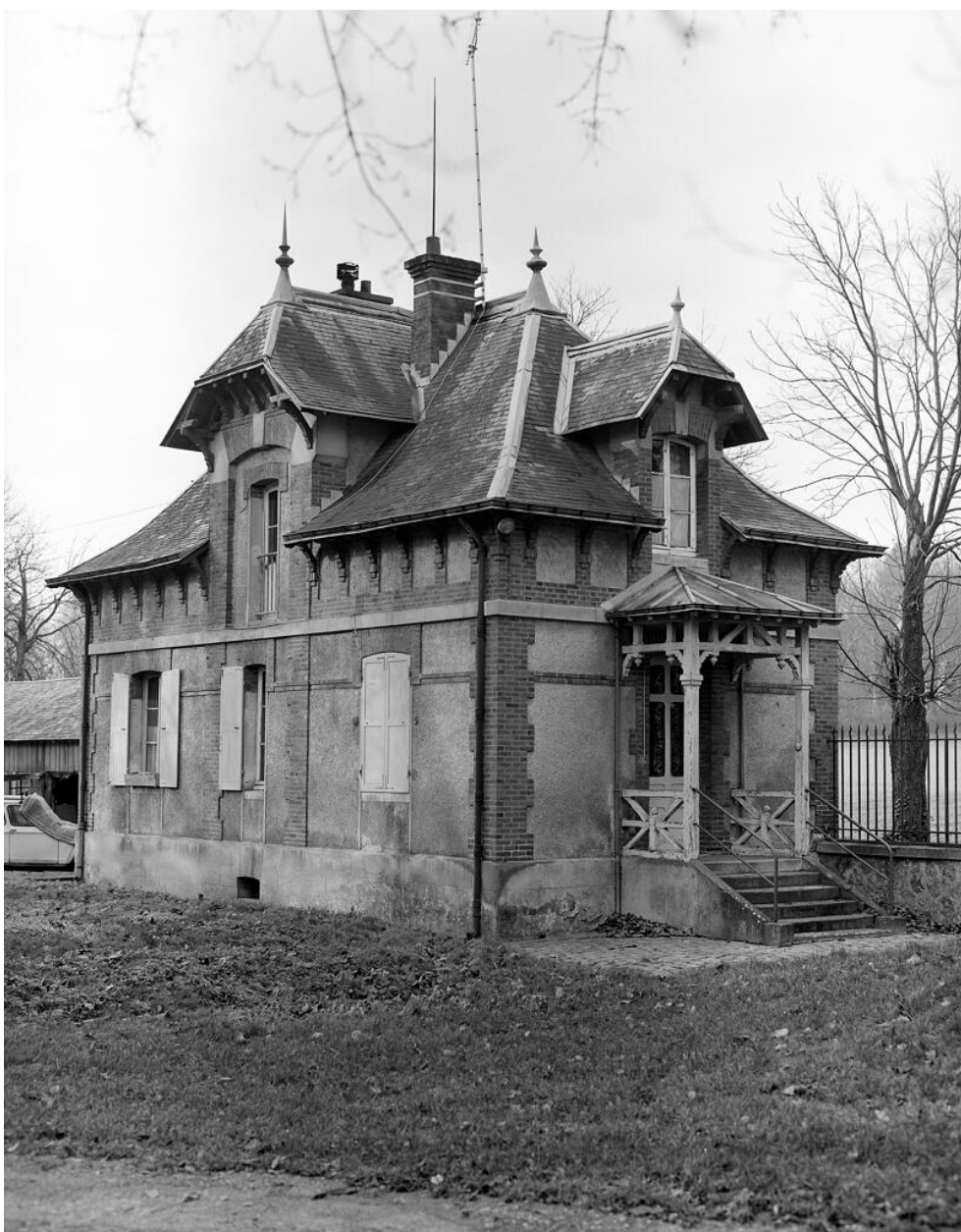
Maison de gardien à l'entrée nord du parc.
