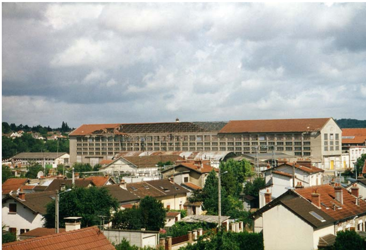
Photo ancienne. Vue générale du grand hall. (Collection particulière).
