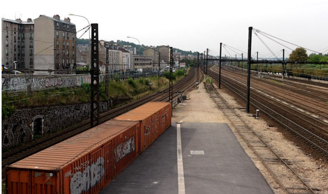
Villeneuve-Saint-Georges . Les lignes de chemin de fer.
