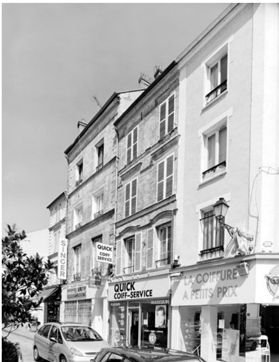
Alignement sur la rue Saint-Aspais (n° 4-8), à l'angle de la rue des Potiers.
