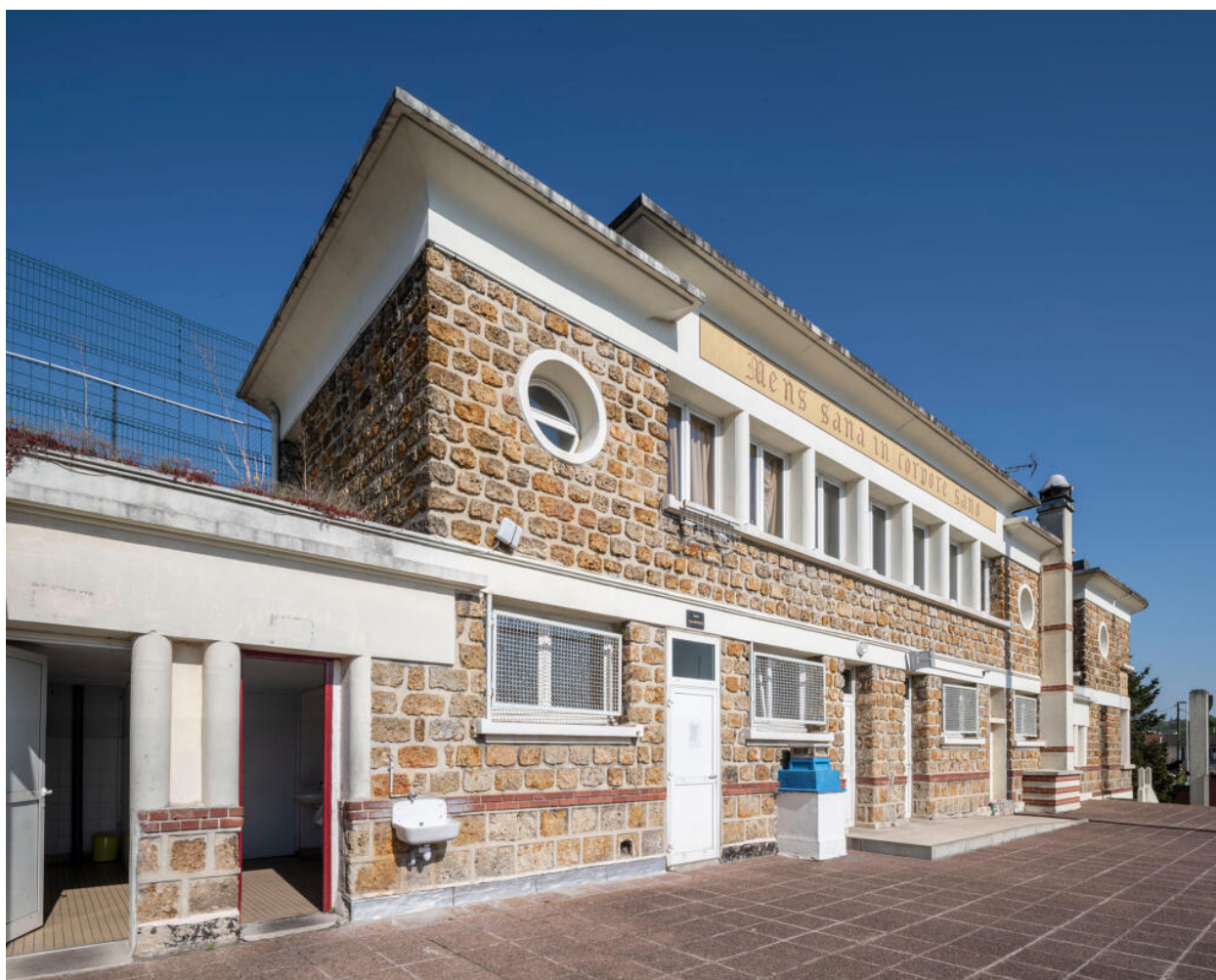
Stade Claude Ripert de Villemomble. Logement du gardien et vestiaires.
