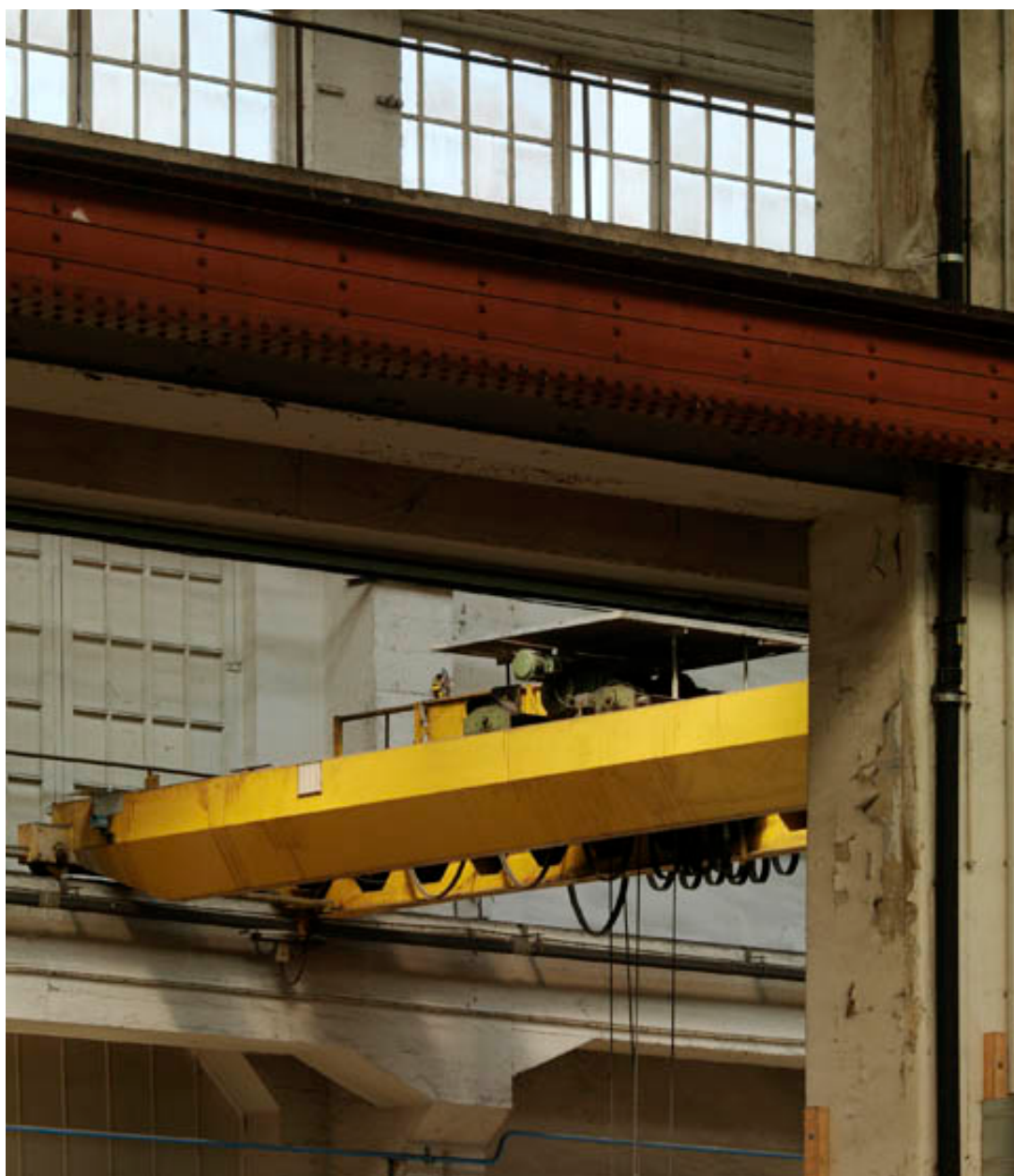
Vue intérieure. Liaison longitudinale nord. Ateliers d'armement puis de mécanique (1918). Actuellement entreprise Jeumont Electric.
