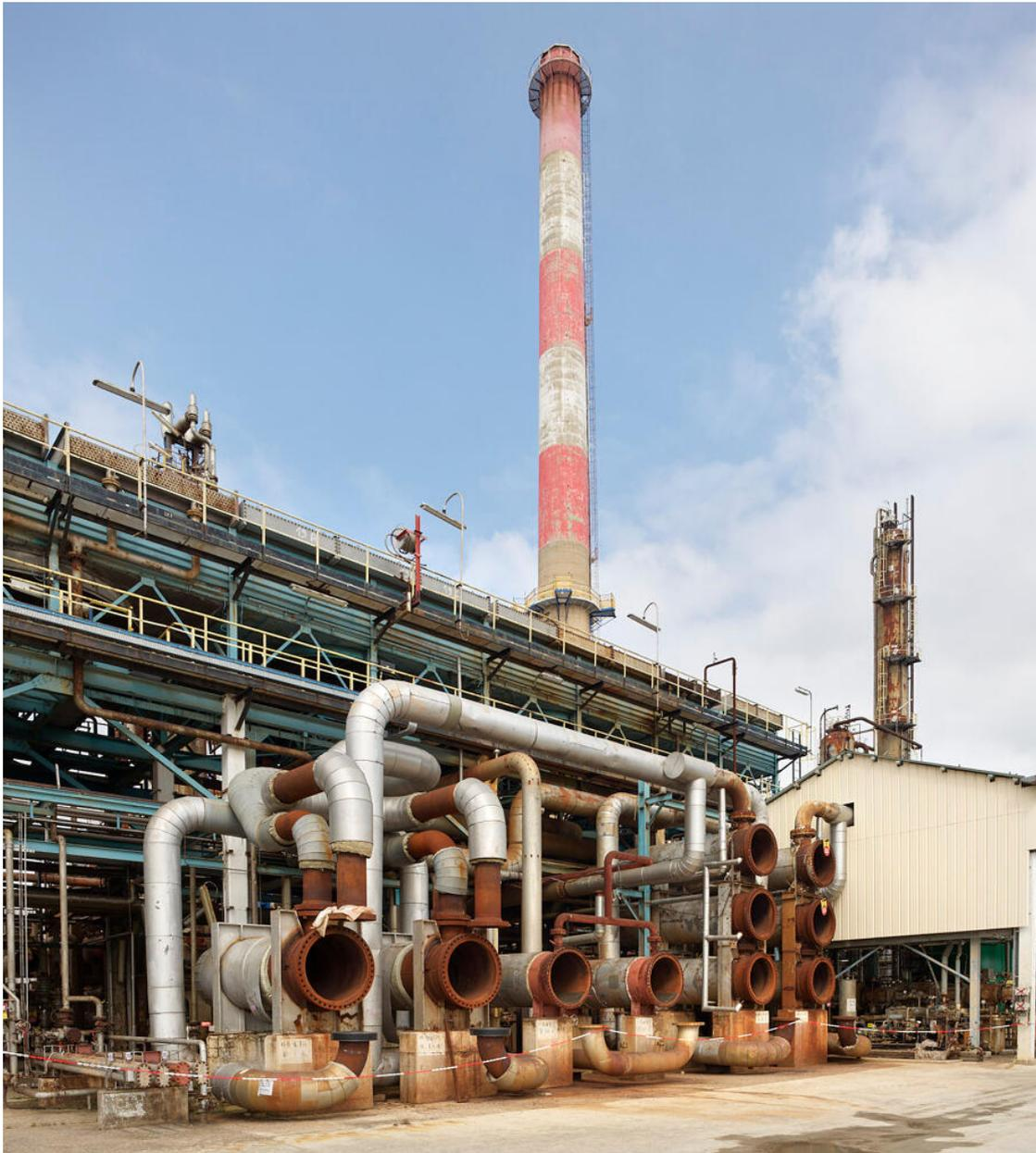
Unités Ouest - Unité 642 Reforming catalytique. Vue d'ensemble des échangeurs à faisceaux tubulaires de l'unité.
