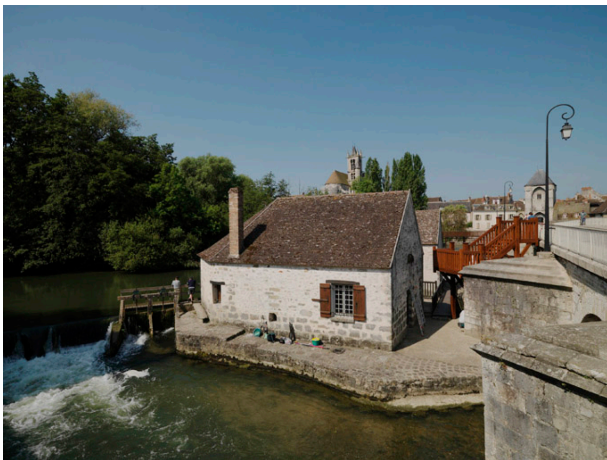
Vue extérieure depuis le pont sur Le Loing.
