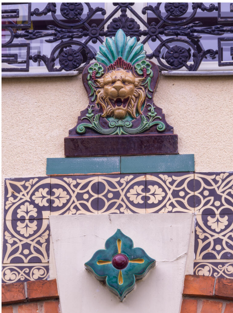
Vue de la façade nord, détail de l'agrafe de la porte d'entrée.
