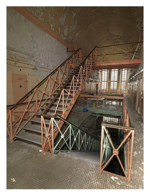
La distribution intérieure du bâtiment cellulaire : chaque étage est desservi par un escalier métallique installé dans l'espace vide central. Vue prise au troisième (et dernier) niveau des cellules.
