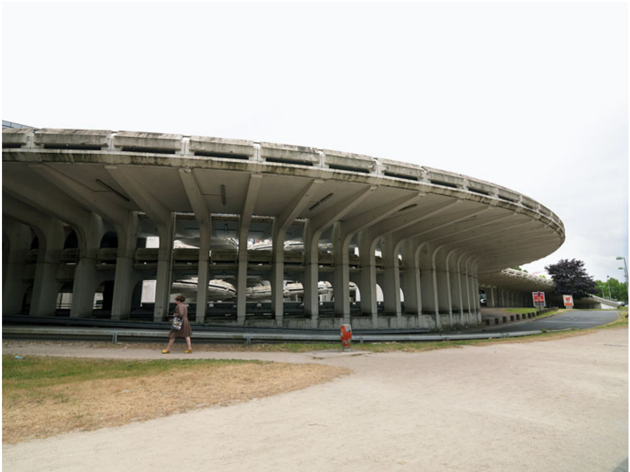
Parking régional du Mont d'Est, 1975-1977. Rampes d'accès.
