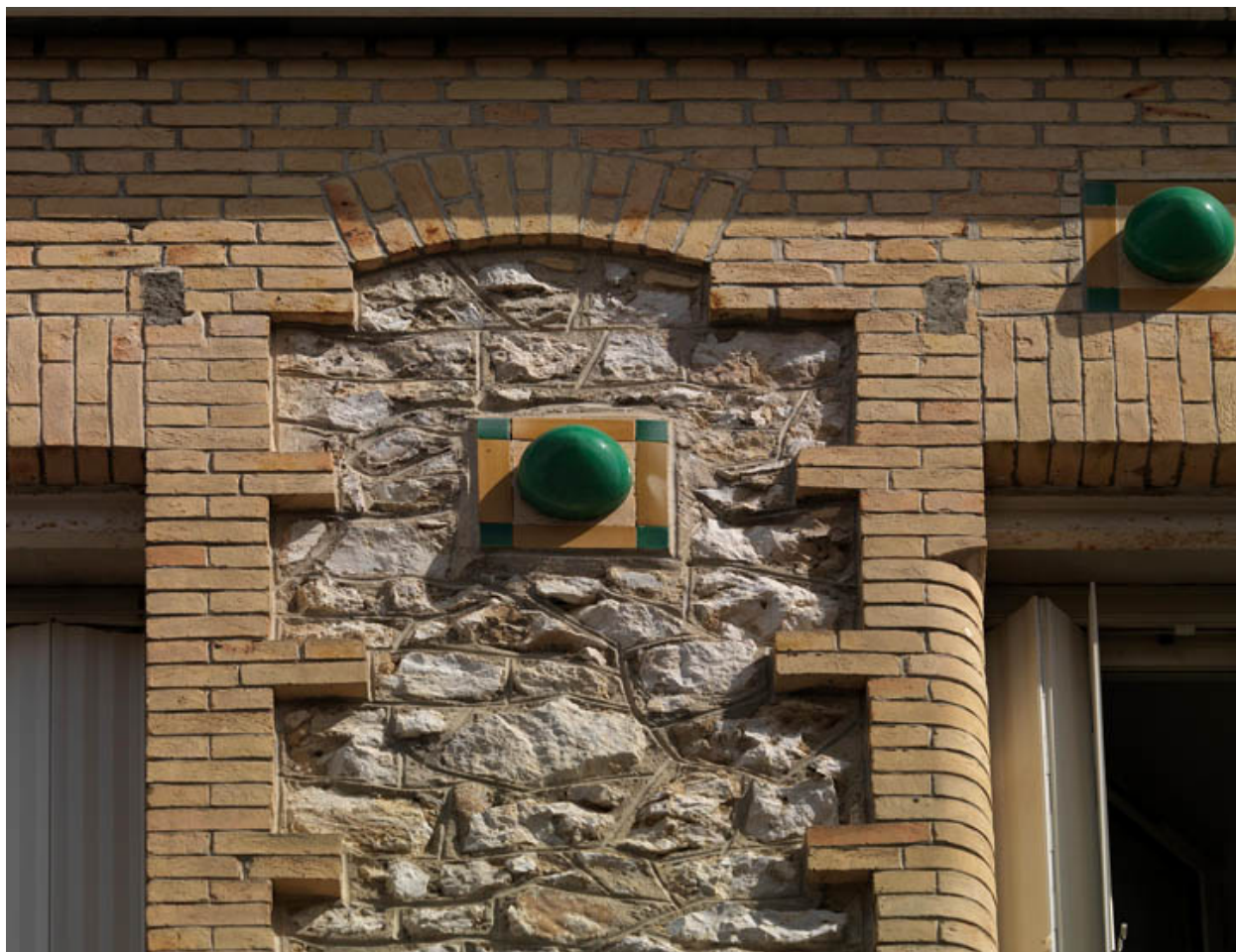
Façade d'un Immeuble rue Pasteur. Briques brunes aux arrêtes arrondies. Des cabochons de céramiques verte animent la façade.
