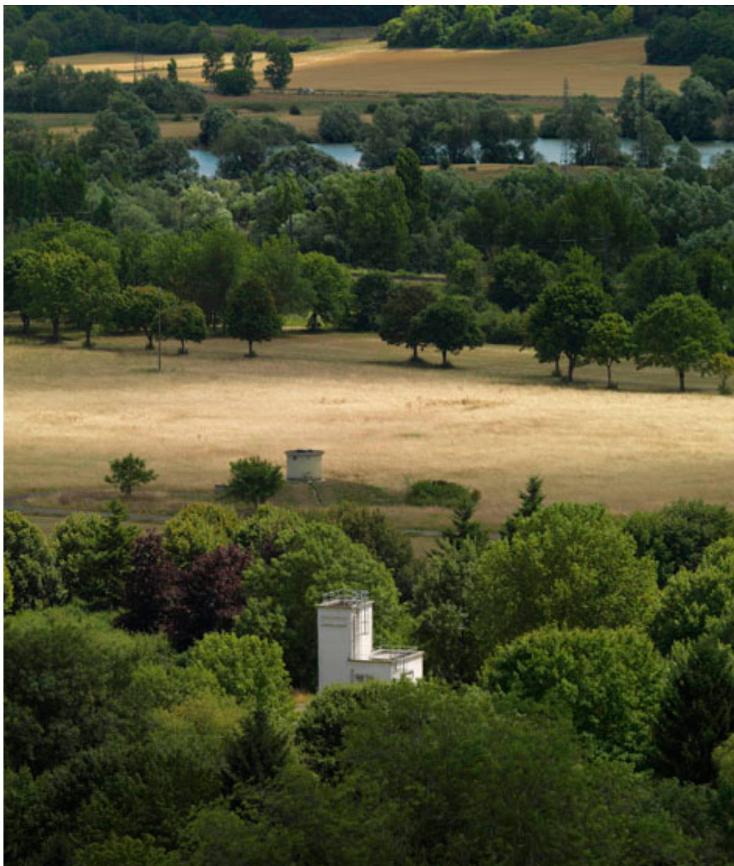
Silos de l'UNCAC Invivo de la Grande Paroisse. Paysages autour du site. Vus depuis la tour de travail du silo 6.
