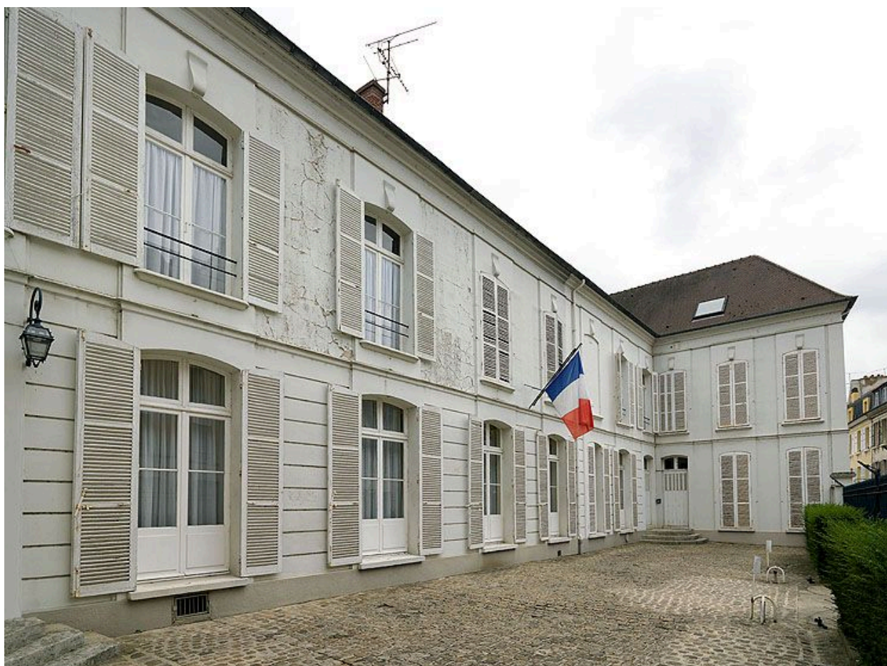
La façade sur cour, vue du nord-ouest.
