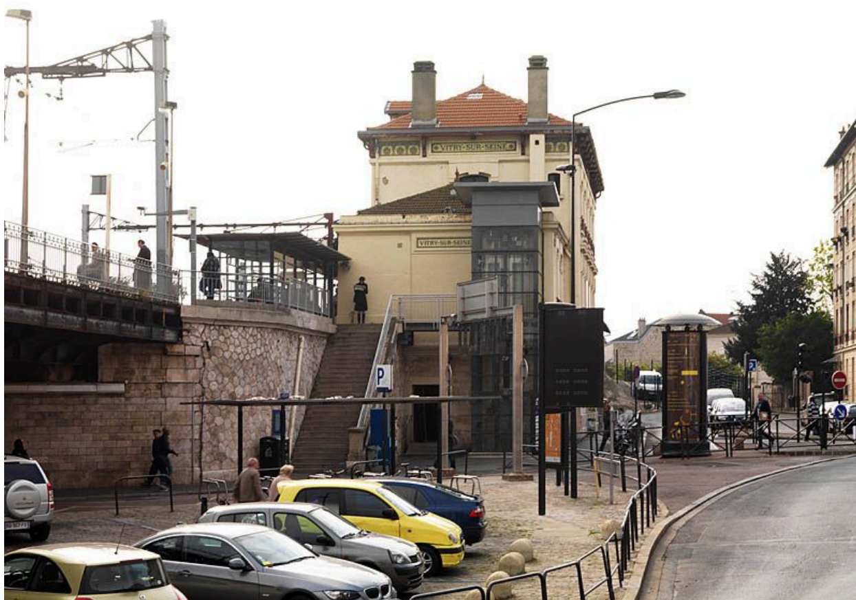
Vitry-sur-Seine, gare, cours de la Gare, place Pierre Semard. Vue rapprochée avec l'escalier extérieur d'accès aux quais.
